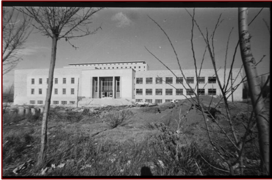
(Edificio actual de la Facultad de Bellas Artes en construcción, 1967. Fondo Santos Yubero, ARCM)
